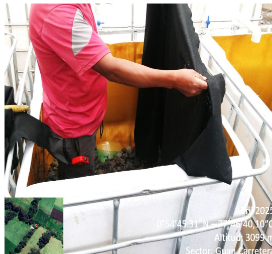
Ilustración 6. Instalación de geotextil
