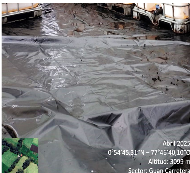
Ilustración 3. Instalación polietileno negro
