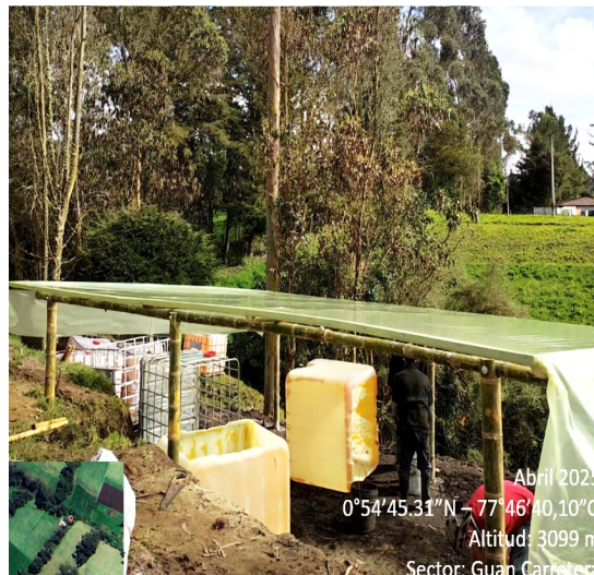
Ilustración 2. Instalación de cubierta
