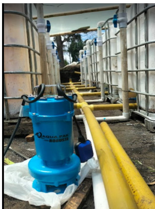
Ilustración 7. Instalación de tubería de drenaje y bomba de impulsión de lodos
