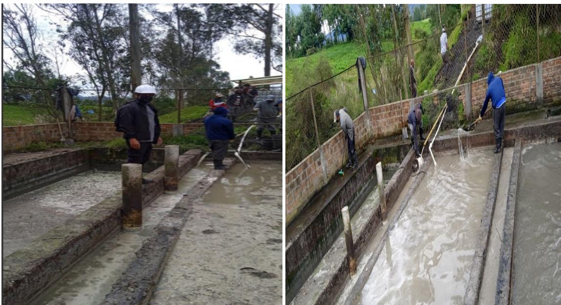
Ilustración 8. Limpieza de la Ptar 26 de abril del 2025
