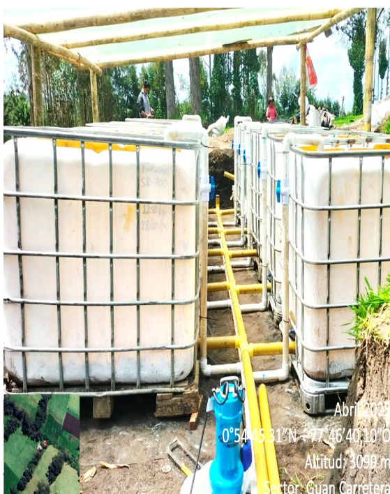
Ilustración 7. Instalación de tubería de drenaje y bomba de impulsión de lodos
