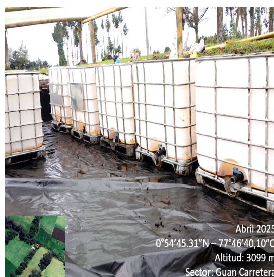
Ilustración 4. Instalación de 10 isotanques
