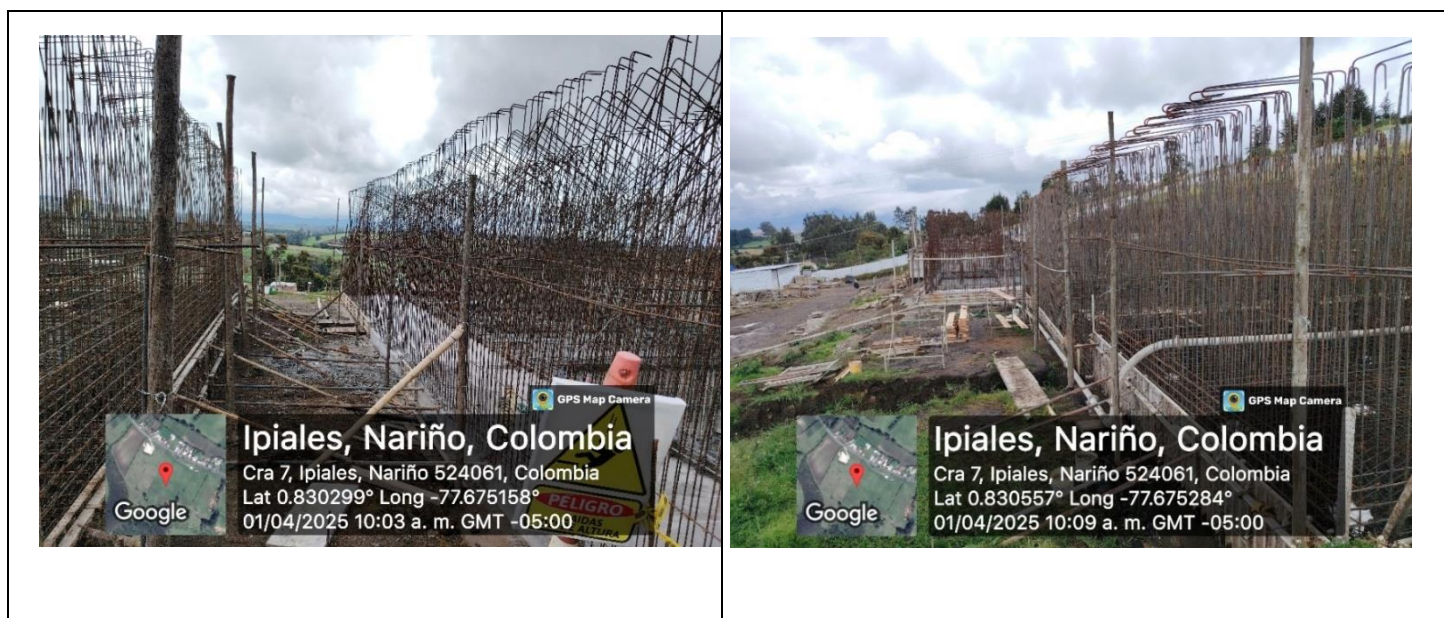
Fotografía 7. Vista lateral estructuras
