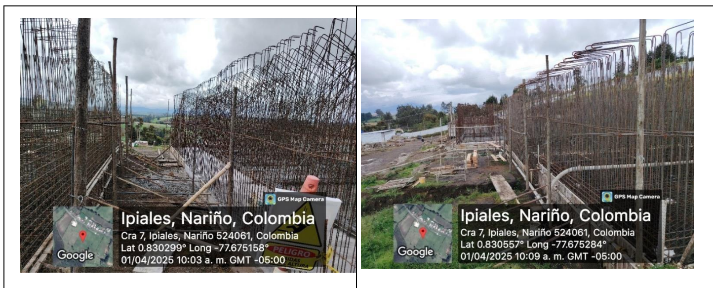
Fotografía 9. Vista lateral estructuras
