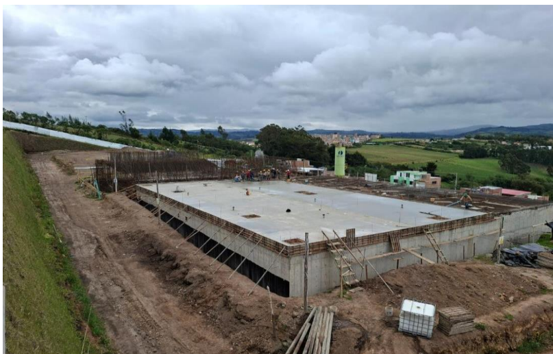
Fotografía 6. Vista panorámica de avance de obra
