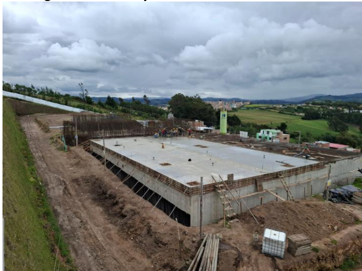
Fotografía 4. Vista panorámica de avance de obra
