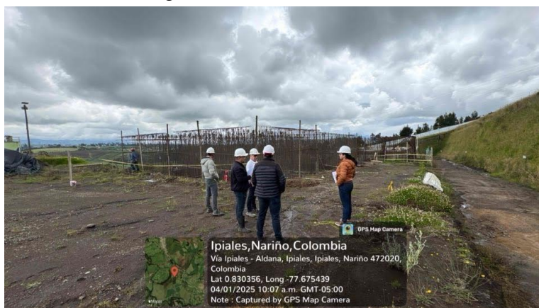
Fotografía 4. Recorrido en la obra
